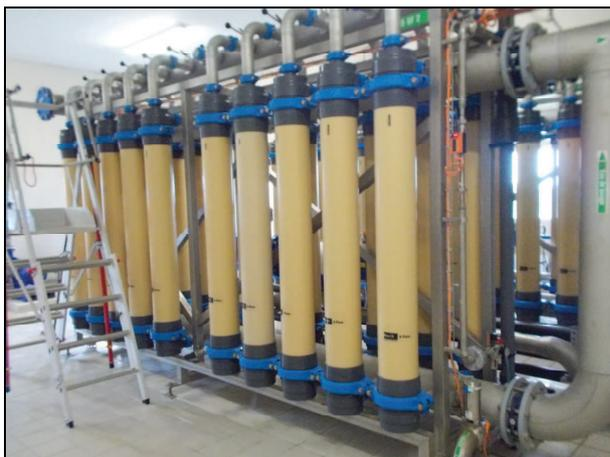
**Photo 5 : Filtration sur membrane**
